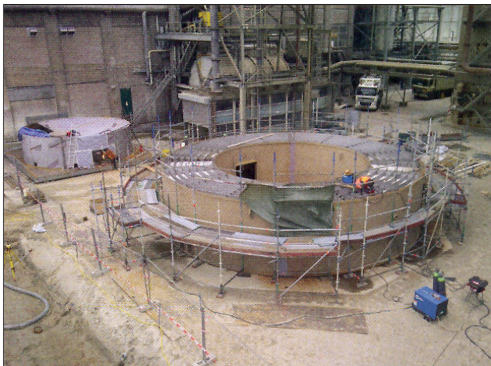
شکل ۳: نصب یک برج دیفوزیون جدید در Dinteloord
